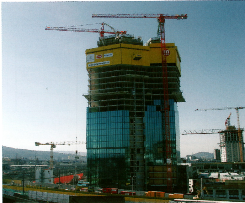
Fig. 5 Stand der Bauarbeiten im März 2010. Construction state in March 2010.
