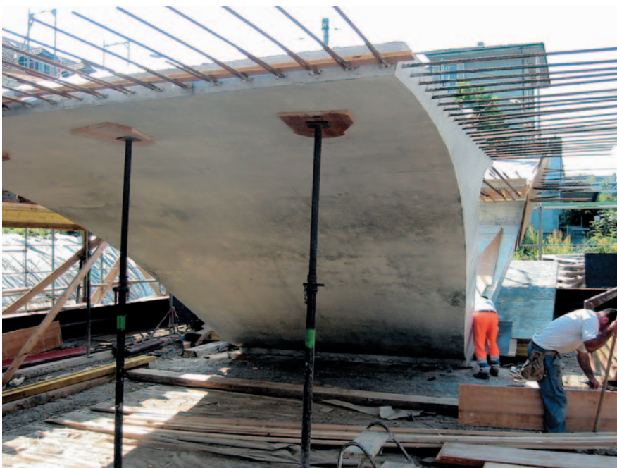
V-Stütze im Bauzustand.
